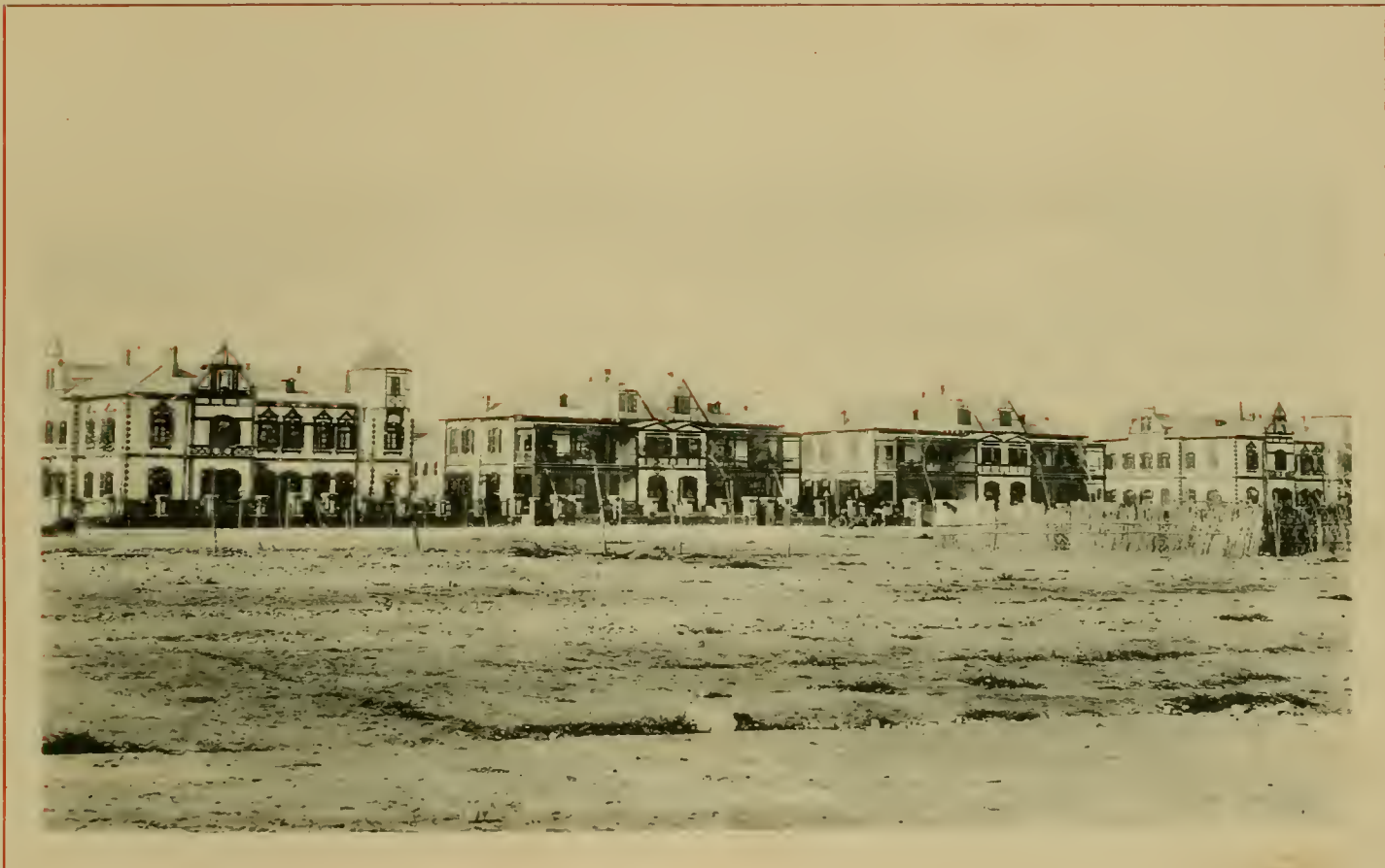
Tientsin. Offizierhäuser nach Fertigstellung
